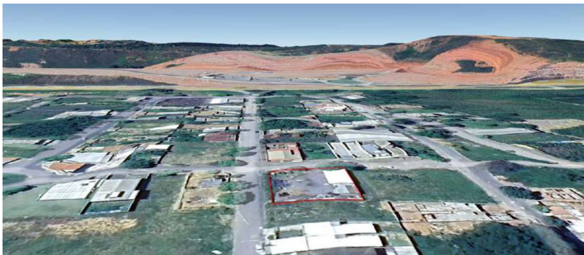
Vista da topografia do norte, em direção ao sul.
